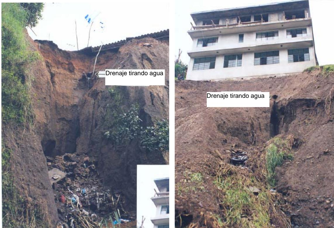
**Figura 5.19** Deslizamientos de tierra provocados por fugas en los sistemas de drenaje
