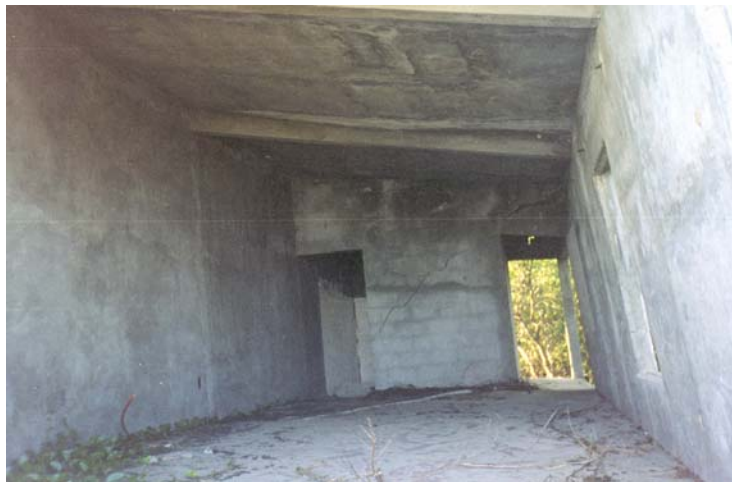
Figura 1.6 Falla por flexión del muro debido al giro de la cimentación en una estructura de mampostería confinada (H. Toledo; Huracán Pauline, Oaxaca, México, 1999)
