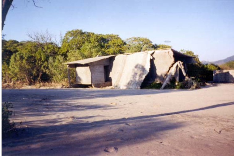
Figura 1.5 Falla de una estructura de mampostería confinada por efecto del viento en las costas del estado de Oaxaca (H. Toledo; Oaxaca, México, 1999)
